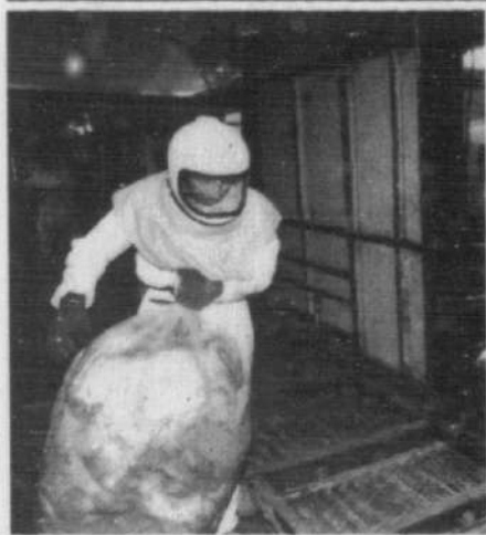
Lavori di bonifica in un vagone «all'amianto»
