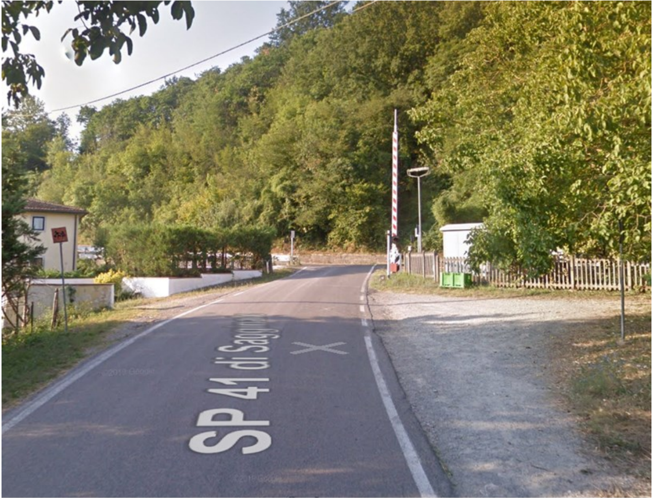
Passaggio a livello sulla SP 41 'Saggiunalese' come si presenta provenendo da La Boschetta. Sulla destra, prima e dopo il passaggio a livello, ci sono delle strade sterrate con fondo cieco.
